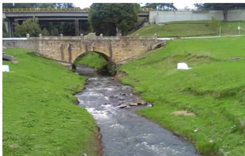
Puente de piedra.
